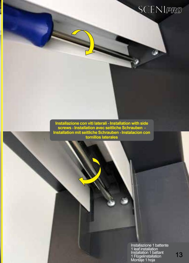
Installazione con viti laterali - Installation with side screws - Installation avec seitliche Schrauben - Installation mit seitliche Schrauben - Instalacion con tornillos laterales
